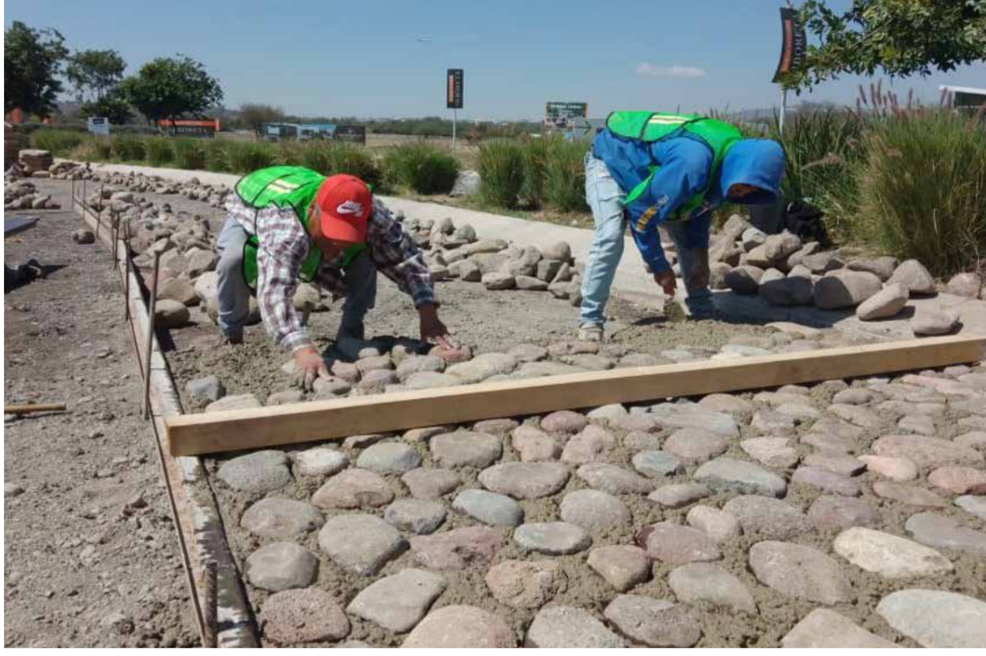
Colocación de empedrado en acceso
