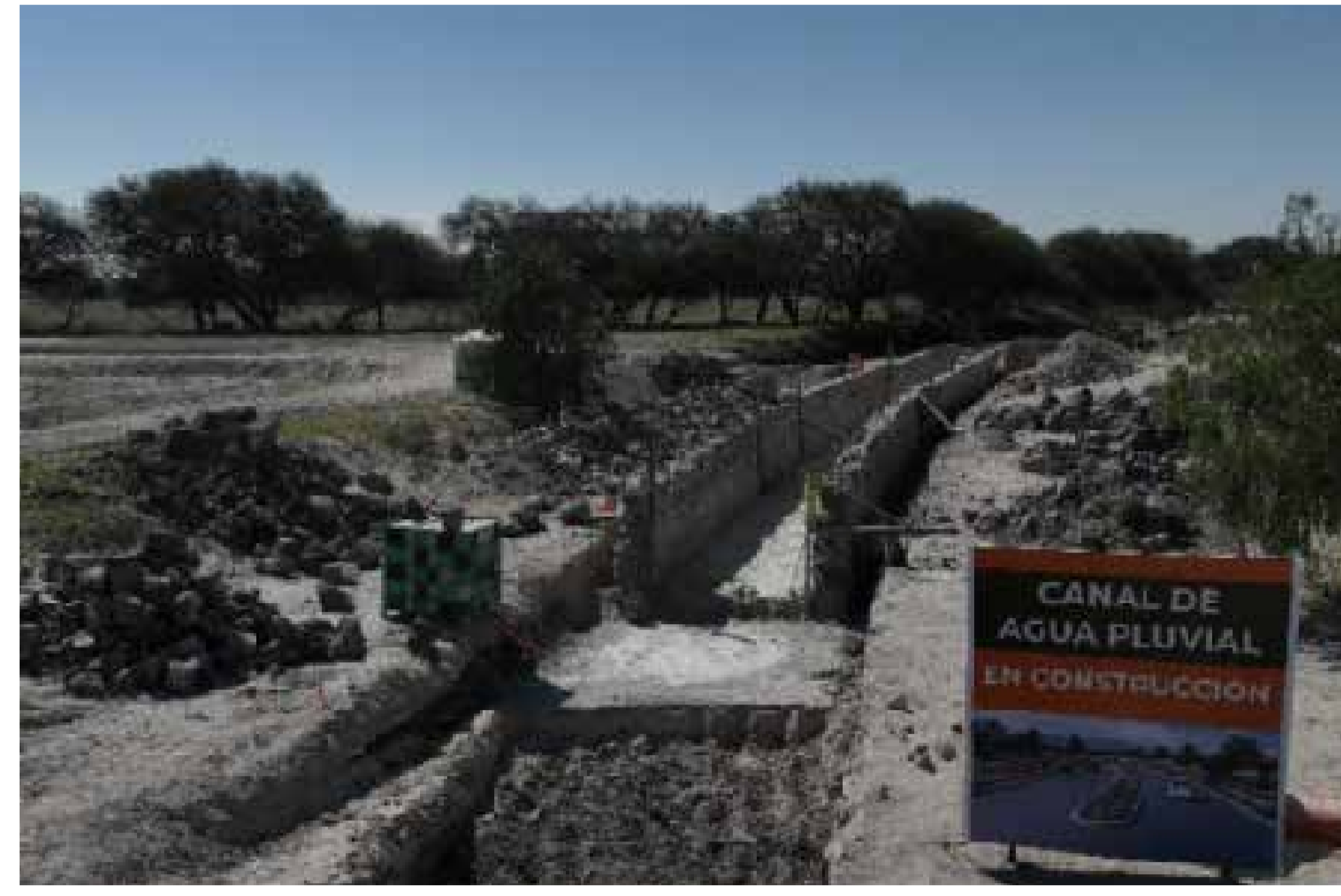
Construcción de canal pluvial
