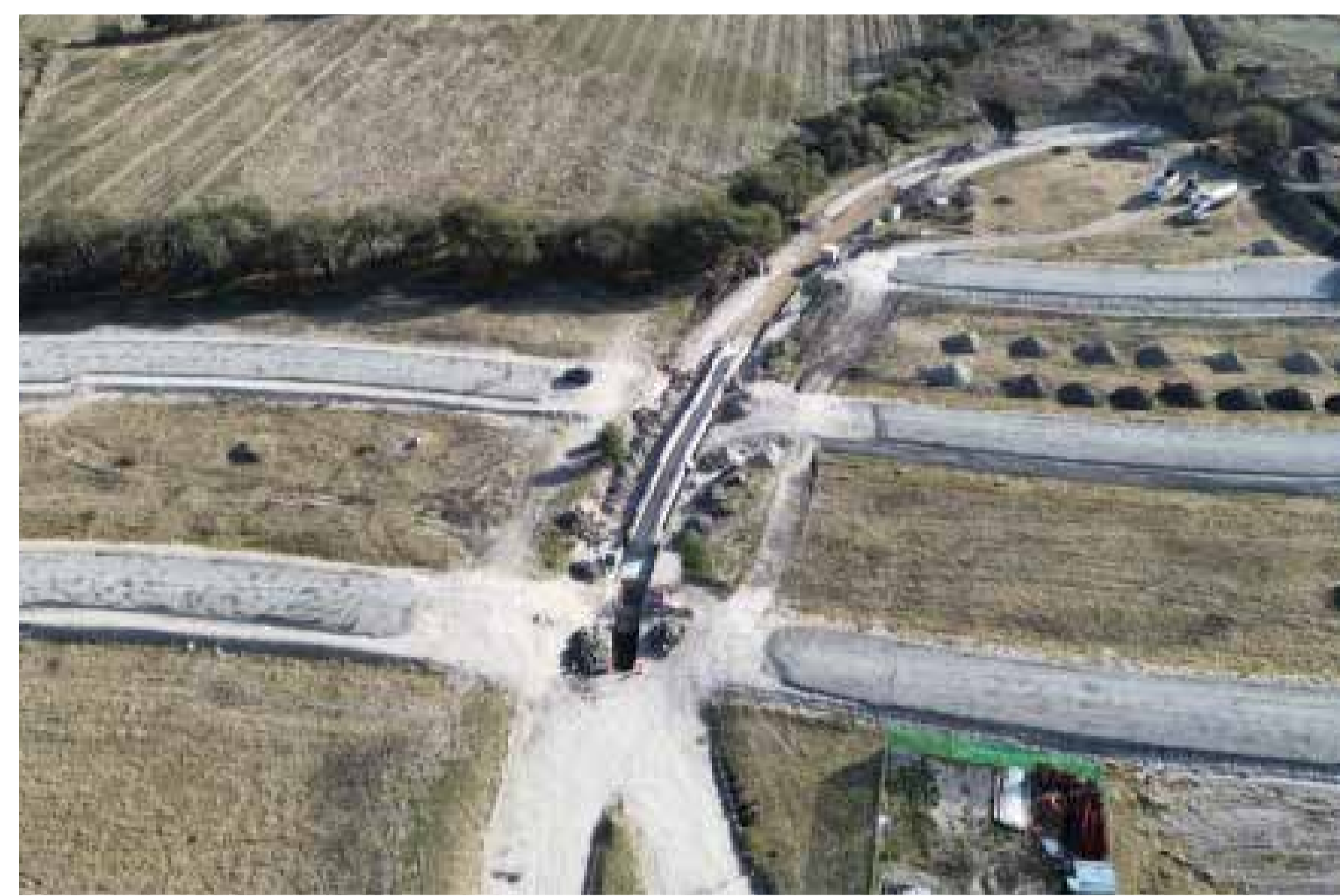
Poreo para protección de riego de impregnación
