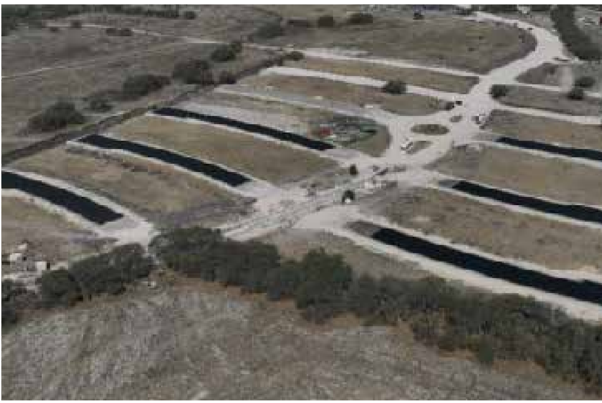
Riego de impregnación en 7 calles Etapa 1
