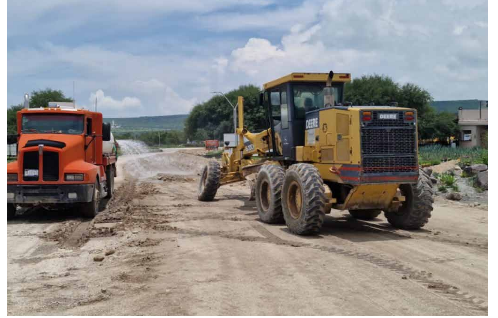
TRABAJOS DE URBANIZACIÓN BLVD. AMAPOLA
