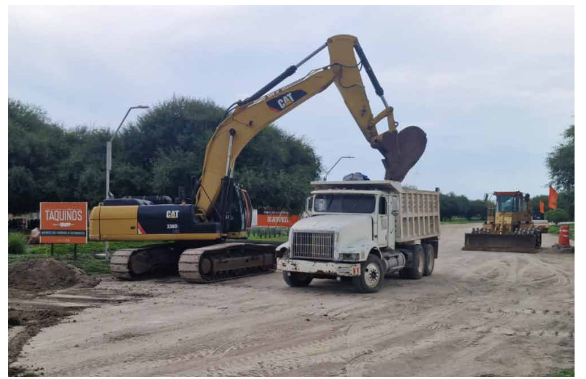
INICIO DE TRABAJOS DE URBANIZACIÓN
