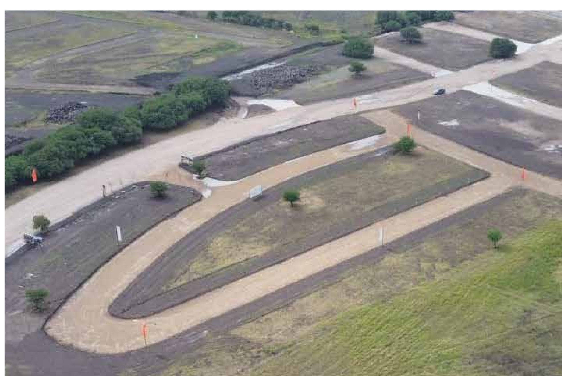
Trabajos con material de tepetate en Tramonte
