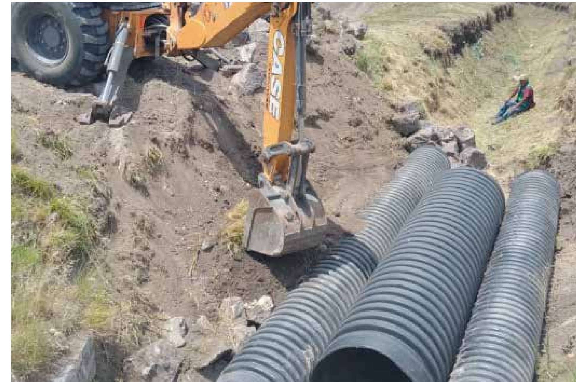
Colocación de tubo para puente en el canal, etapa 2
