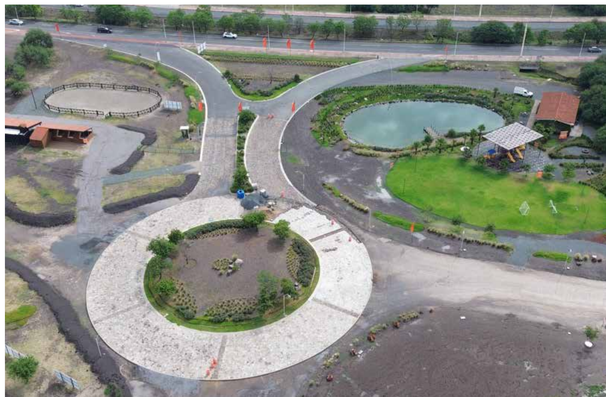
Avance del 80 % del tapete de laja en sección de la glorieta
